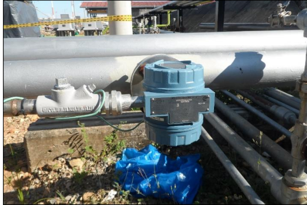
Figura 11. Transmisor de Densidad
