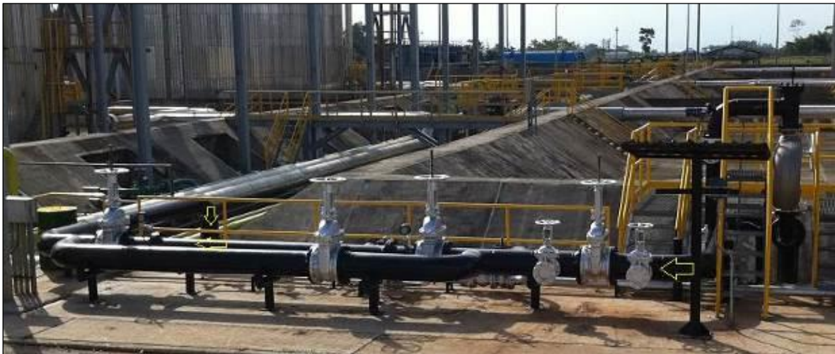
Figura 4. Sistema de Dilución (Mezclador Estático)
