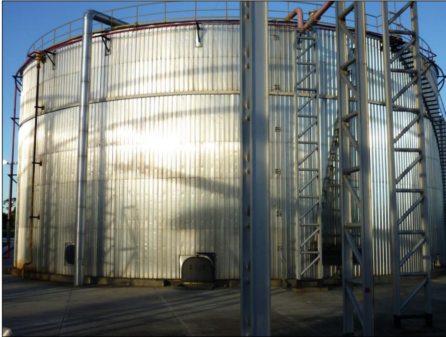
Figura 5. Tanque de Lavado
